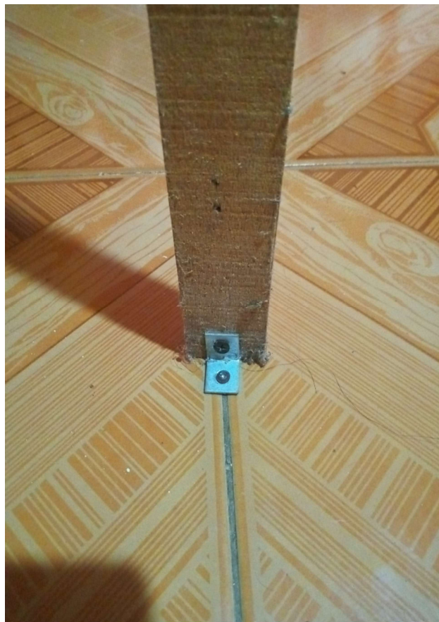
Fig. 2 Fijar al piso con tornillos
